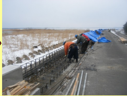
鉄筋組み立て作業
