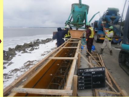
生コンクリート打設
