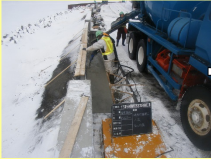
底板コンクリート打設
