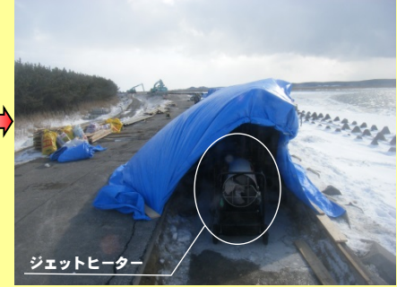
コンクリート養生
