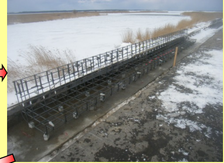
鉄筋組み立て完了
