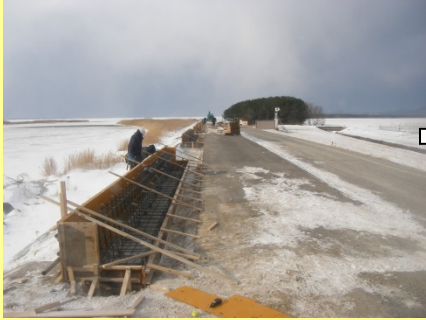
コンクリート型枠組み立て
